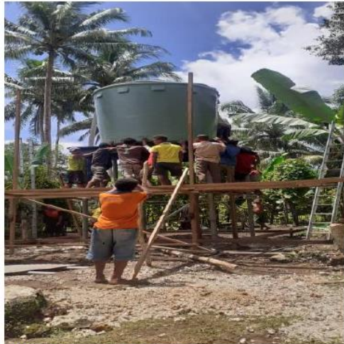
(d) Tubowada Header Tanker installation
